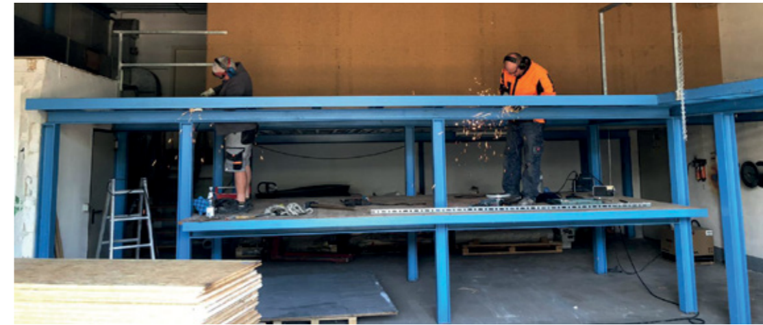
Die Räumlichkeit für den neuen Laser-Roboter musste erst geschaffen werden.
